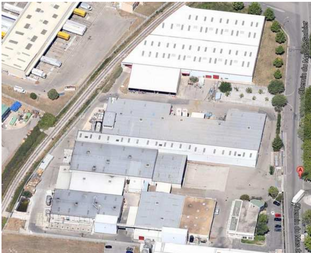
Fig 2. Vue aérienne du site industriel
